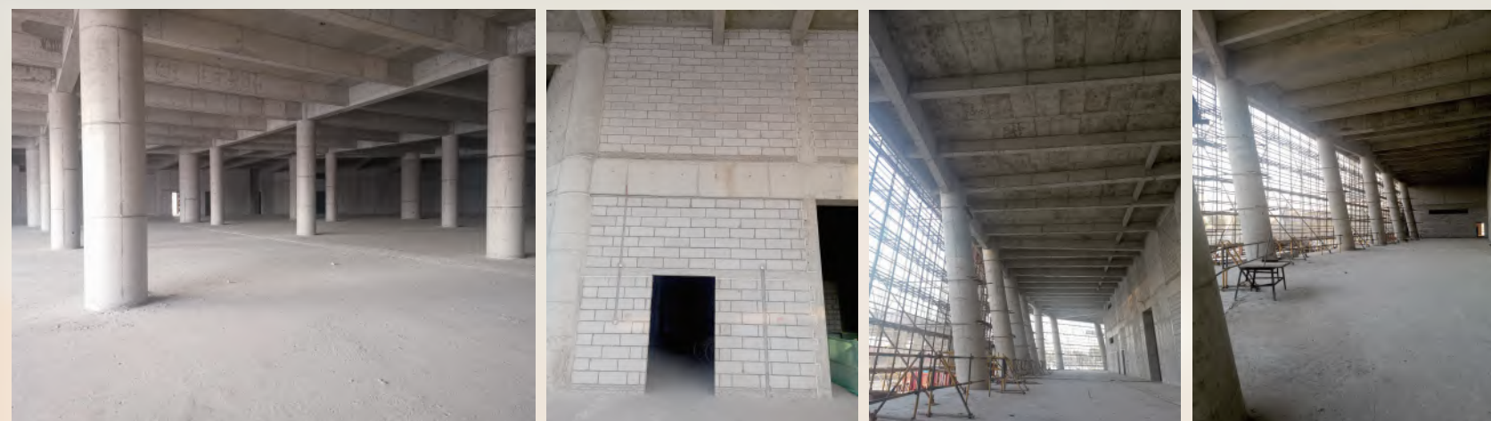
主体结构圆柱
