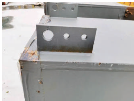
钢柱吊装、固定耳板
