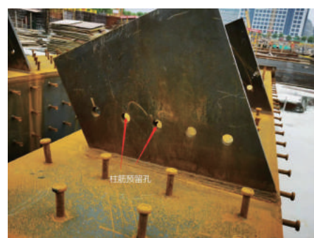
钢牛腿柱筋预留孔
