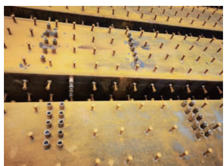
折梁底筋上斜与钢柱套筒连接困难
