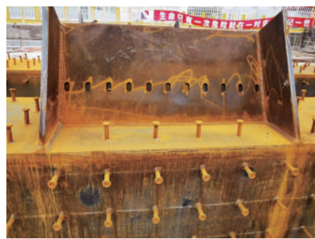
钢牛腿柱筋预留孔
